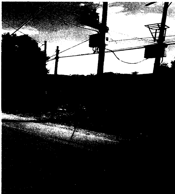
FOTO N° 02: ESTRUCTURA PUNTO DE DISEÑO – RED AEREA 10KV.
