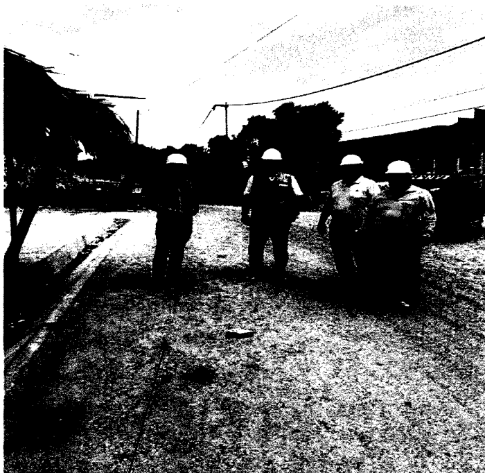
FOTO N° 08: TRAMO RED SUBTERRANEA - EXTERIOR DEL DPA.
